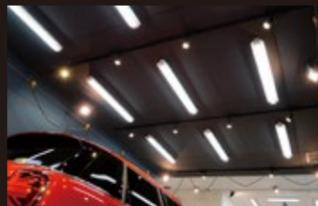
LED・HID・ハロゲン・メタルハライド・蛍光灯など照度や色温度が異なる光源を死界を作らずミックスさせ、微細なキズも見逃さず磨き上げる為の照明を装備しています。
